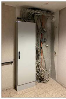
Um die im Gebäude verlaufenden Steigleitungen zur Versorgung der Elektroverteilungen zu den Flucht- und Rettungswegen hin brandschutzsicher abzuschotten, wurden im Zuge von Umbaumaßnahmen in einem Seniorenzentrum die entsprechenden Bereiche jeweils mit Brandschutznischen in L-Form aus Massivwänden ausgebaut.
