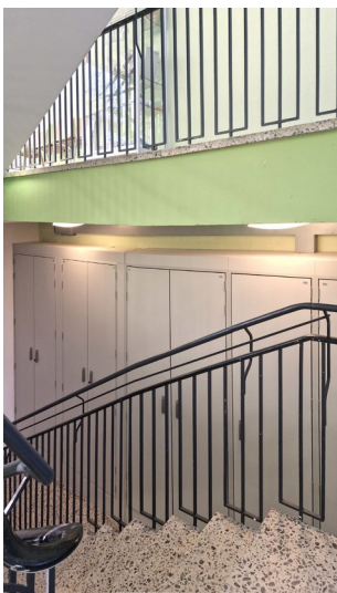
Großflächige Brandschutzabtrennung im Treppenhaus eines Schulgebäudes
