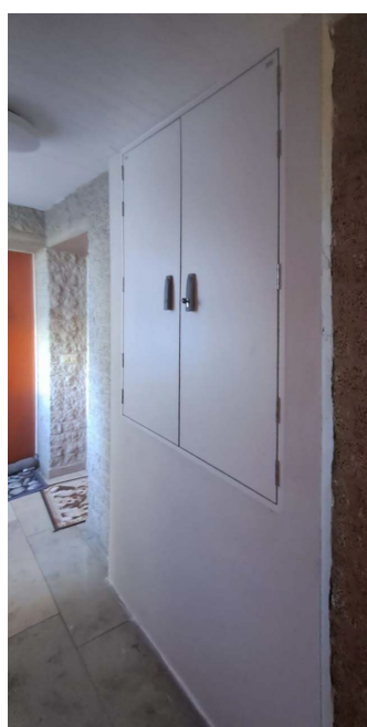
Schachtausbildung und Abschottung der elektrischen Verteileranlagen in den Fluren eines Seniorenheims
