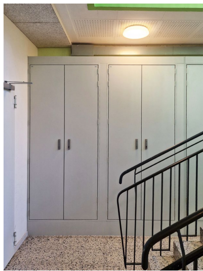
Großflächige Brandschutzabtrennung im Treppenhaus eines Schulgebäudes
