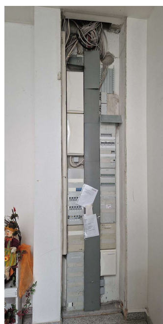
Brandschutzabschottung der Installationsschächte im Bereich der Flucht- und Rettungswege in einem Kindergarten
