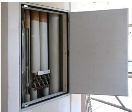
4. Bei ausgebautem Türflügel diesen beginnend am obersten Scharnier einsetzen
