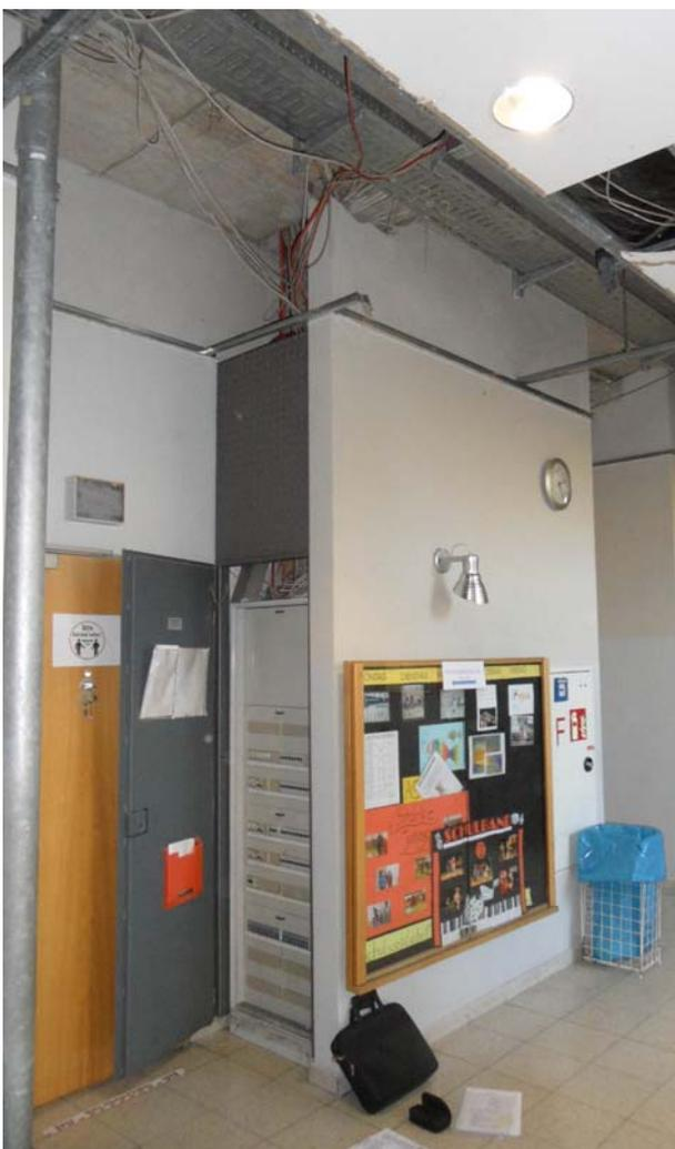
Bei der Planung von Modernisierungsmaßnahmen in einem Schulgebäude wurde festgestellt, dass die Verteileranlagen in den Installationsschächten nur durch einfache Stahltüren ohne Feuerwiderstand zu den davorliegenden Flucht- und Rettungswegen hin abgetrennt waren.
